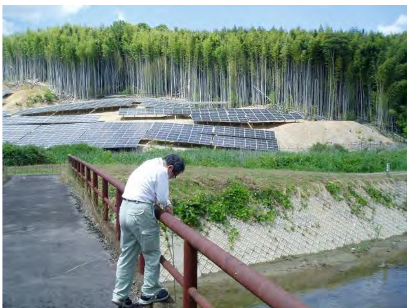
St16 最下流部 小松橋 東に太陽光発電設備設置中(24 年 6 月)
